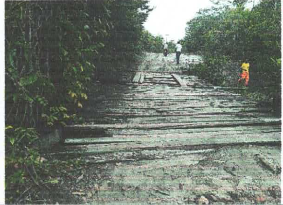
FOTO 05 – 1.400 M –PONTE DE MADEIRA – VÃO 11,50 M S/ O RIO SÃO GERONIMO
