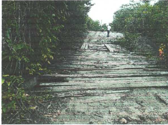
FOTO 05 A – 1.400 M –PONTE DE MADEIRA – VÃO 11,50 M S/ O RIO SÃO GERONIMO
